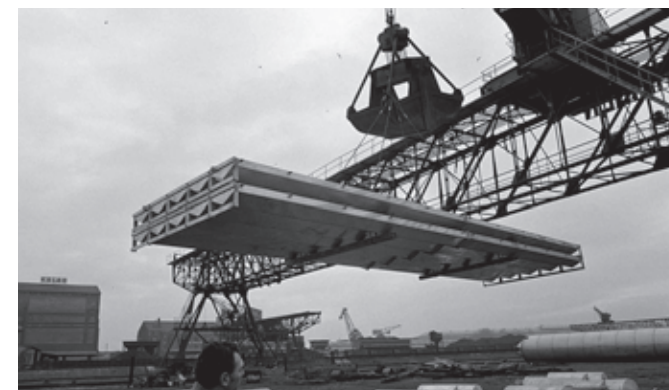
Montage des neuen Bootssteigs, 1978
