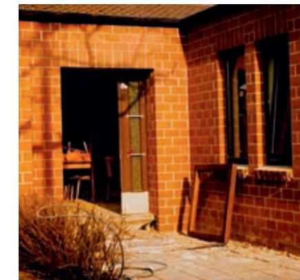
Eingang Bootshaus beim Umbau
